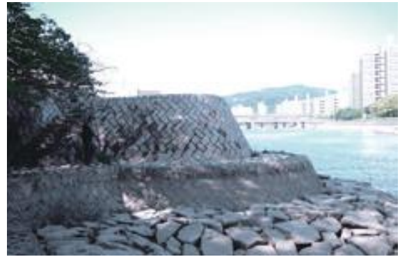
図7 現在の水制工
