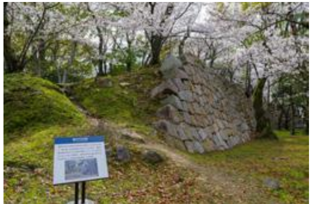
本丸東側の崩れかけた石垣 福島正則が、武家諸法度違反を咎められた際に破却したと考えられる石垣。
